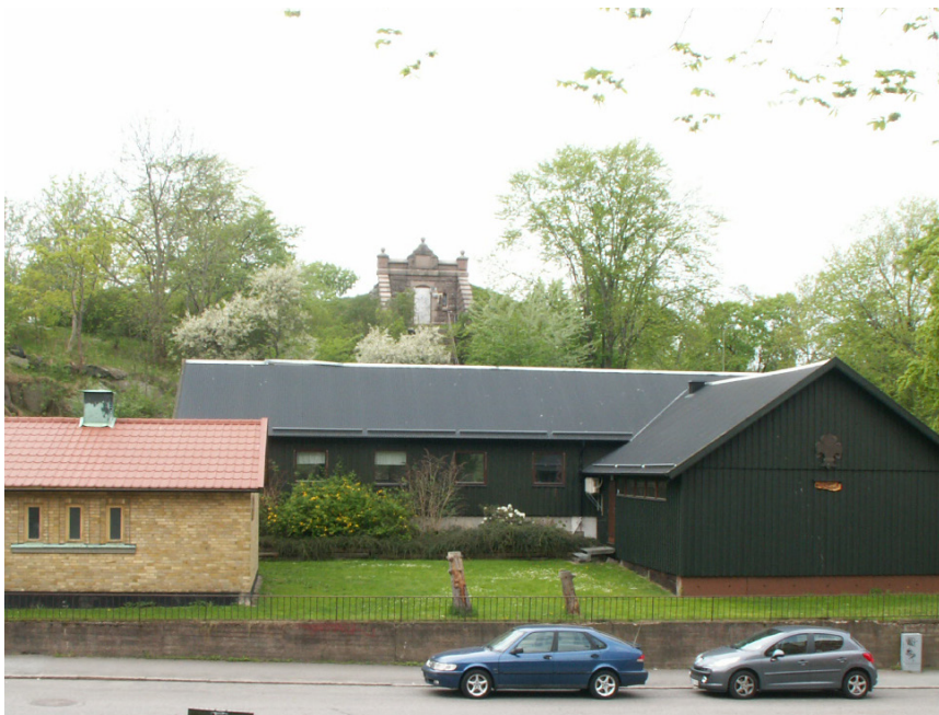
Föreningslokal och pumpstation som föreslås rivas.
