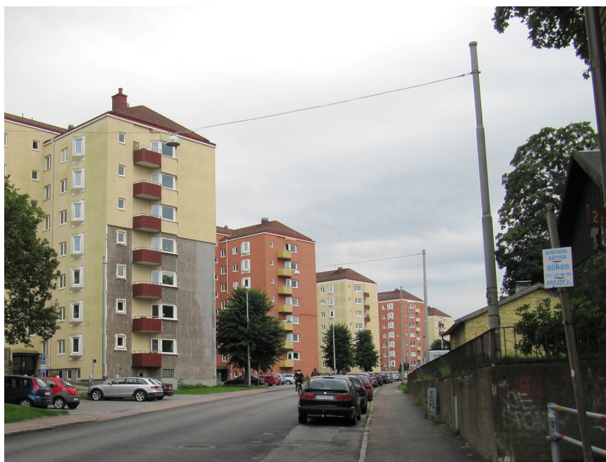
Gaturummet längs Kabelgatan med planområdet till höger.
